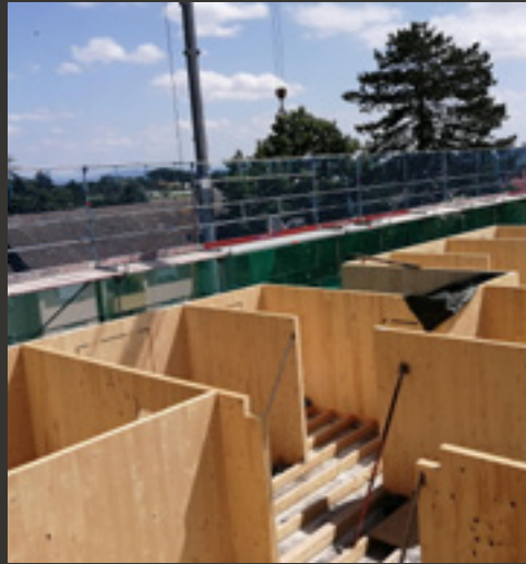
Aufstockung in Holzbauweise
