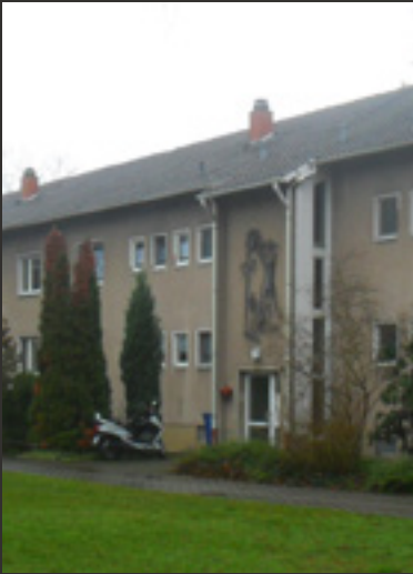
Bestand vor Aufstockung
